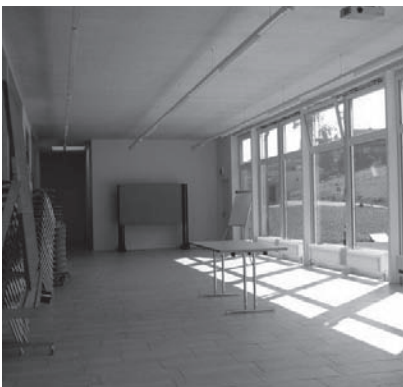
Fertigstellung der Aulaerweiterung
