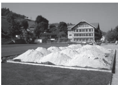
Sanierung und Erweiterung der bestehenden Turn- und Sportanlagen SETS Beginn der Bauarbeiten September 2011
