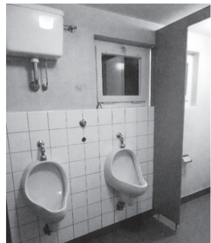
WC-Anlagen im Untergeschoss
